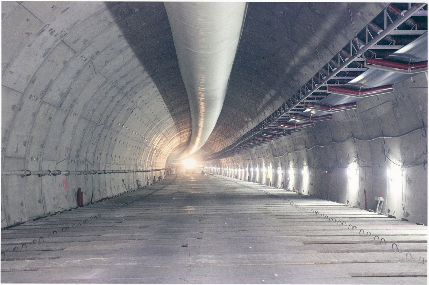
Interior de uno de los túneles con la losa de tráfico ejecutada. Interior of one of the tunnels with the road slab completed.
